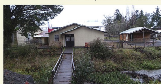
Antiguas instalaciones de la Escuela Epsón de Ensenada.
